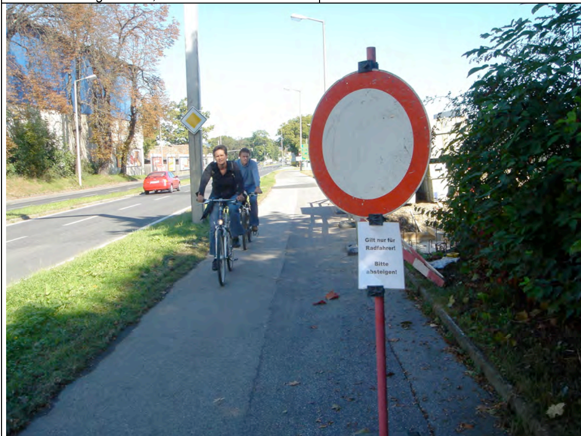
Baustelle Puntigamerstr., am Wochenende
